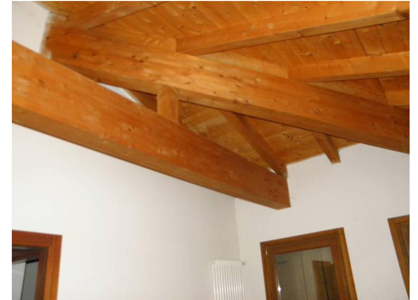
VISTA PARTICOLARE COPERTURA
