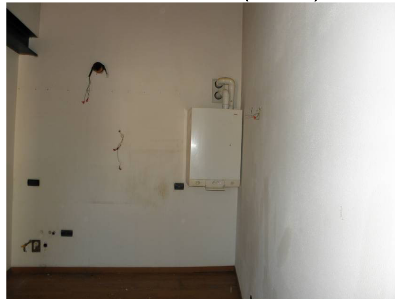
VISTA CUCINA (CALDAIA) 2°P
