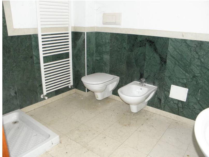
VISTA BAGNO 3°P
