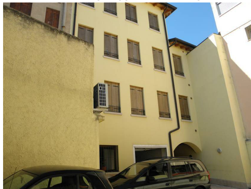
VISTA CORTILE INTERNO
