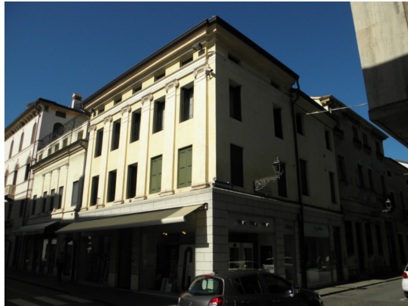
VISTA SUD EST
