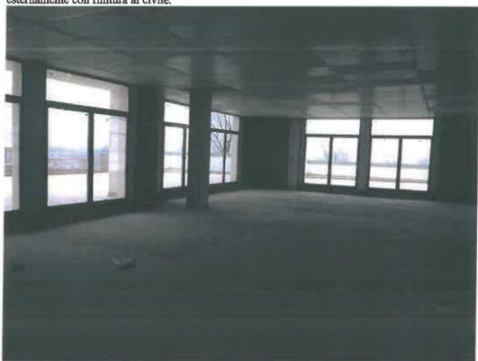
La pavimentazione dei corridoi e delle terrazze è in piastrelle ceramiche cm. 30x30, mentre la pavimentazione all'interno del locale principale è ancora al grezzo (soletta in cls armato con massetto soprastante).
