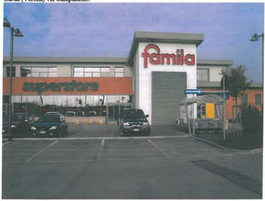
L'immobile sopra individuato è composto da un unico locale tipo open space, con murature perimetrali in laterizio, orizzontamenti in c.a.p., intelaiature in c.a. internamente al grezzo ed esternamente con finitura al civile.
