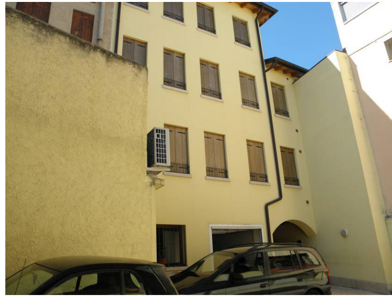
VISTA SUD CORTILE INTERNO
